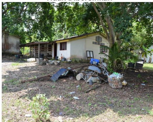
Gambar 3.15 Kawasan Kuarters Berpenghuni Tidak Dibersihkan
