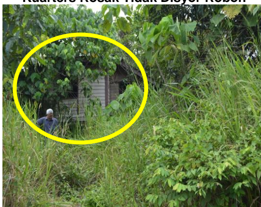
Gambar 3.9 Kuarters Rosak Tidak Disyor Roboh
