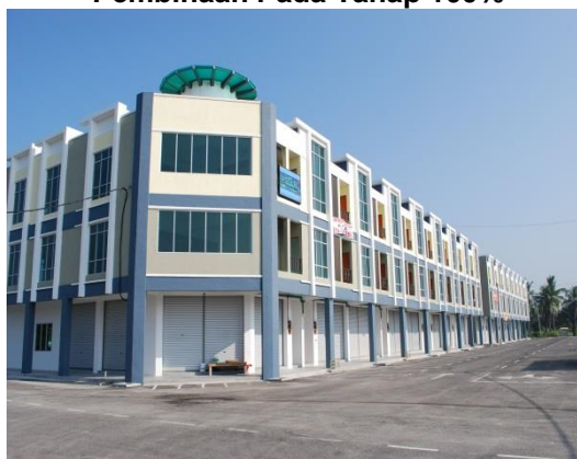
Gambar 1.4 Pembinaan Pada Tahap 100%
