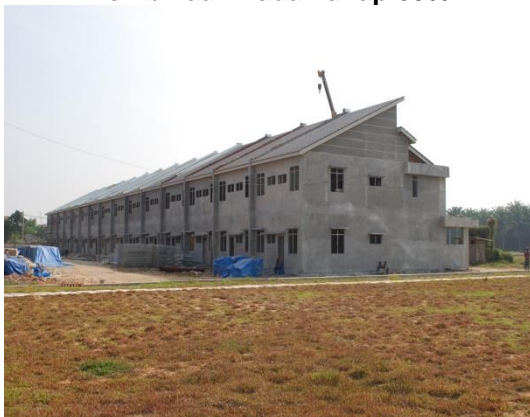
Gambar 1.1 Pembinaan Pada Tahap 60%
