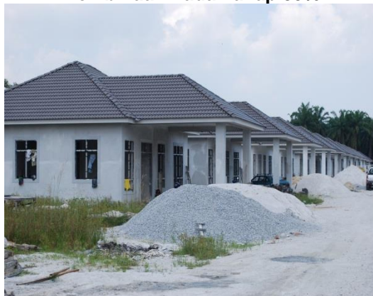
Gambar 1.2 Pembinaan Pada Tahap 80%
