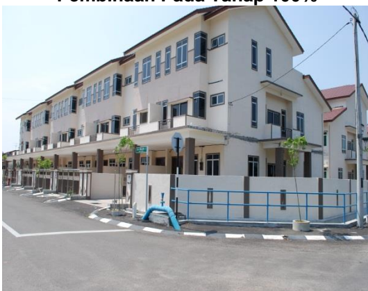
Gambar 1.3 Pembinaan Pada Tahap 100%
